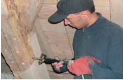
Dieptebehandeling door injectie.
